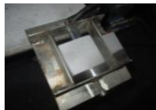
Gambar 8. Pemasangan Material Pada Jig
